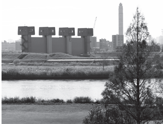
> 1 荒川と隅田川とを仕切る岩淵水門（青水門）（東京都北区）
